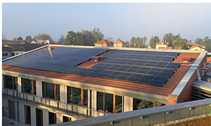
**231** panneaux sur le toit de l'école d'une puissance de 100kWc
