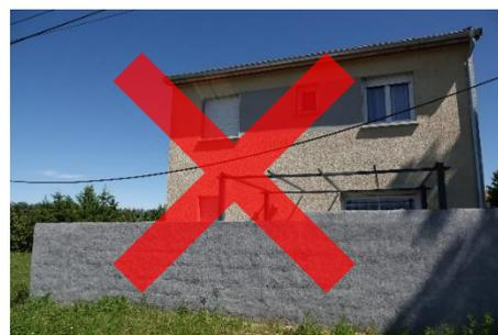
Mur en moellons mal enduits
