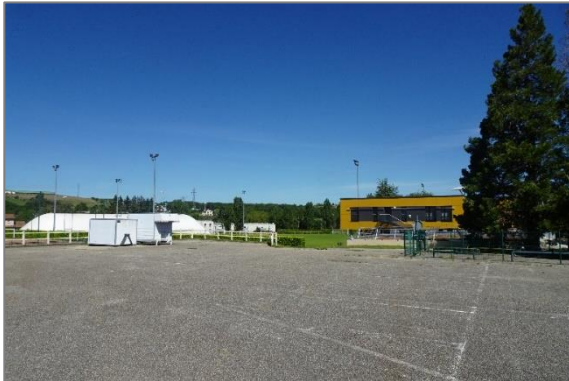
Parkings très minéraux : Parking de l'Europe
