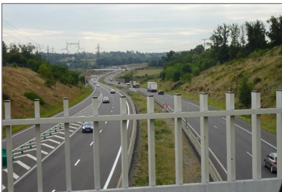
L'A89 depuis le pont qui la surplombe
