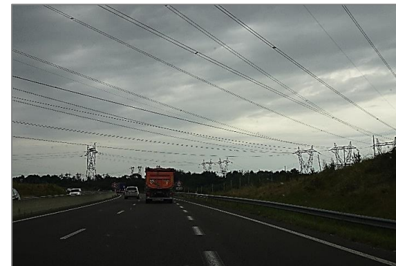
Couloir de lignes électriques depuis l'autoroute
