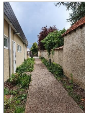
Circulation piétonne plantée
